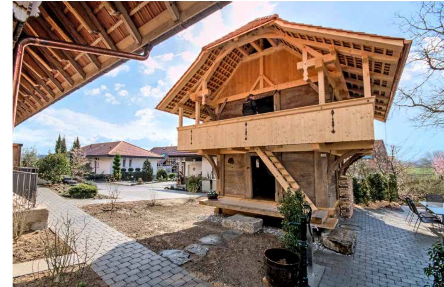
Der Speicher in Wallenbuch aus dem Jahr 1709 ist komplett renoviert.
